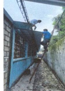
Foto 2: Sustitución de lámina por lámina troquelada
