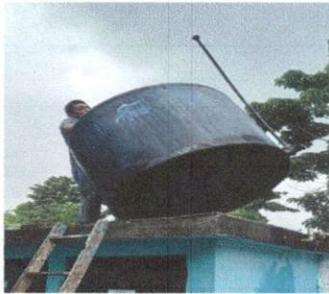
Foto 5: Sustitución de depósito de agua de 1100 lt
